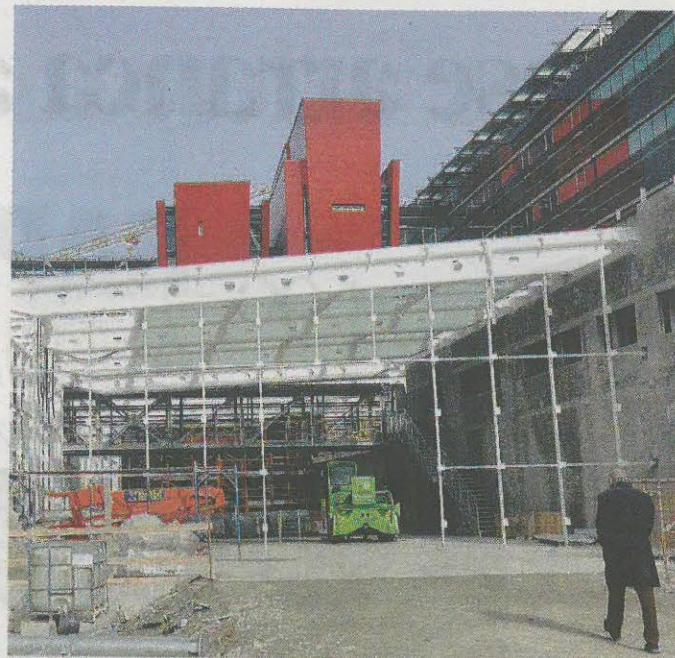
Il cantiere del nuovo ospedale di Alba-Bra sulla collina di Verduno.
